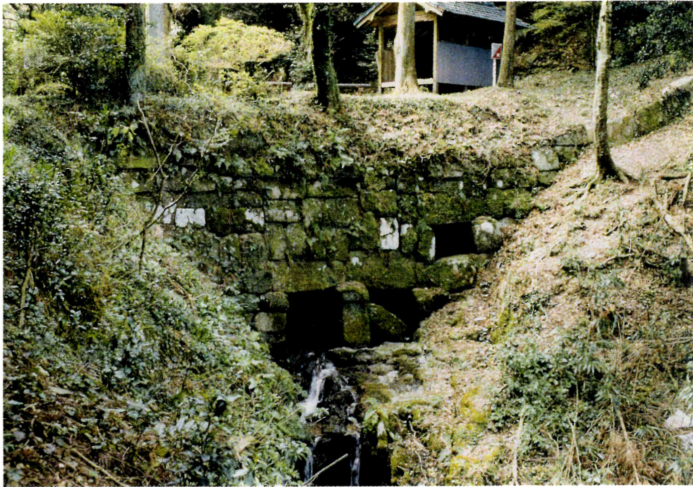
写真図版 187 雷山神籠石の北水門
